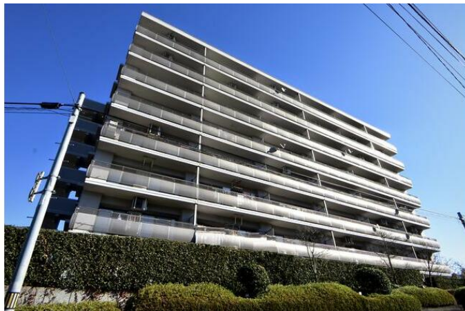
只今、室内をリノベーション工事中。2025年1月31日に完工予定。
