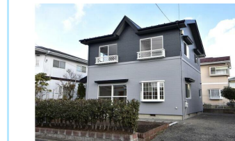
駐車スペース4台（玄関前1台+東側縦列3台）
